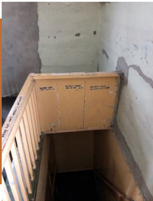
Trappegang mellom kjøkkenet og barnerommet.
