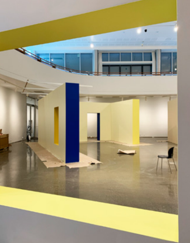
Bygging og maling av løse vegger.
